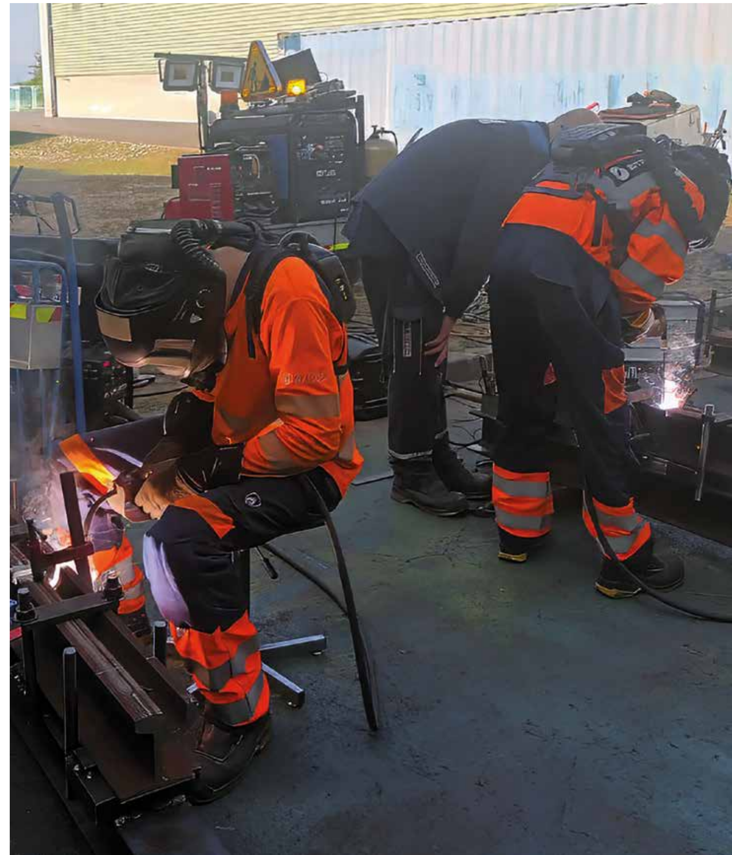
Qualifizierungsschulung zum Stumpfschweißen von Schienen mit TRI S RW-O
