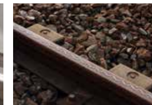
6. Auftragsschweißen am Schienenkopf
