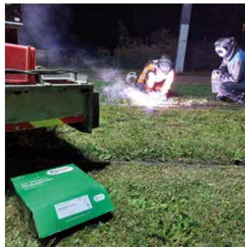
Vor-Ort-Unterstützung bei der Reparatur eines Weichenabschnitts mit HARDFACE 19 9 6-O
