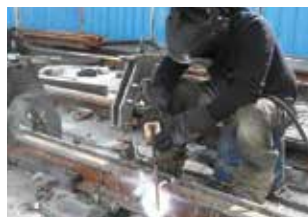
2. Schienenverbindungs-schweißen
