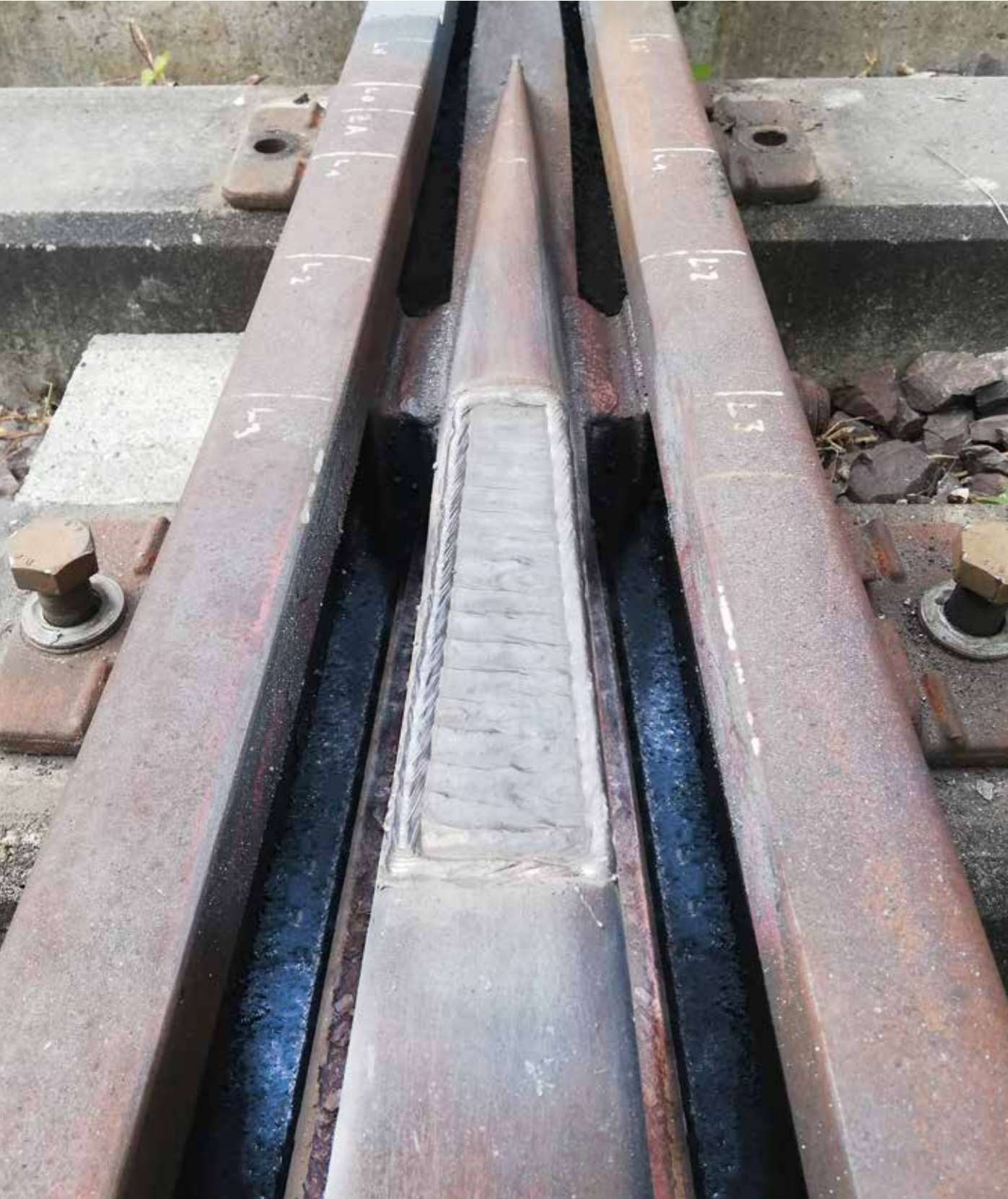
Riparazione su binario con HARDFACE AP-O.
