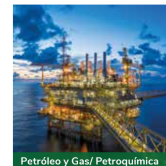
Petróleo y Gas/ Petroquímica
