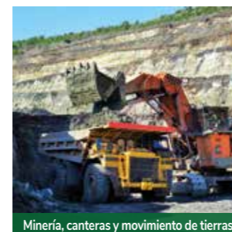
Minería, canteras y movimiento de tierras
