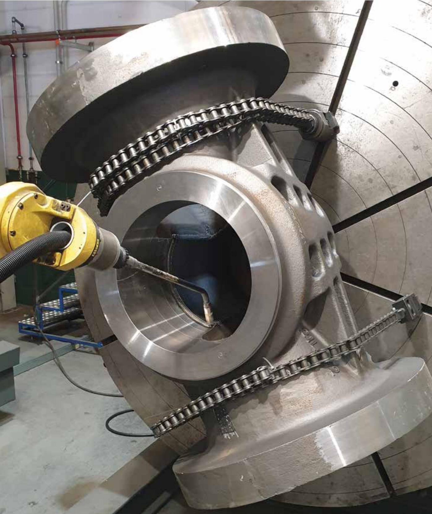
Revestimiento robotizado de una válvula con STELLOY 21-G.
