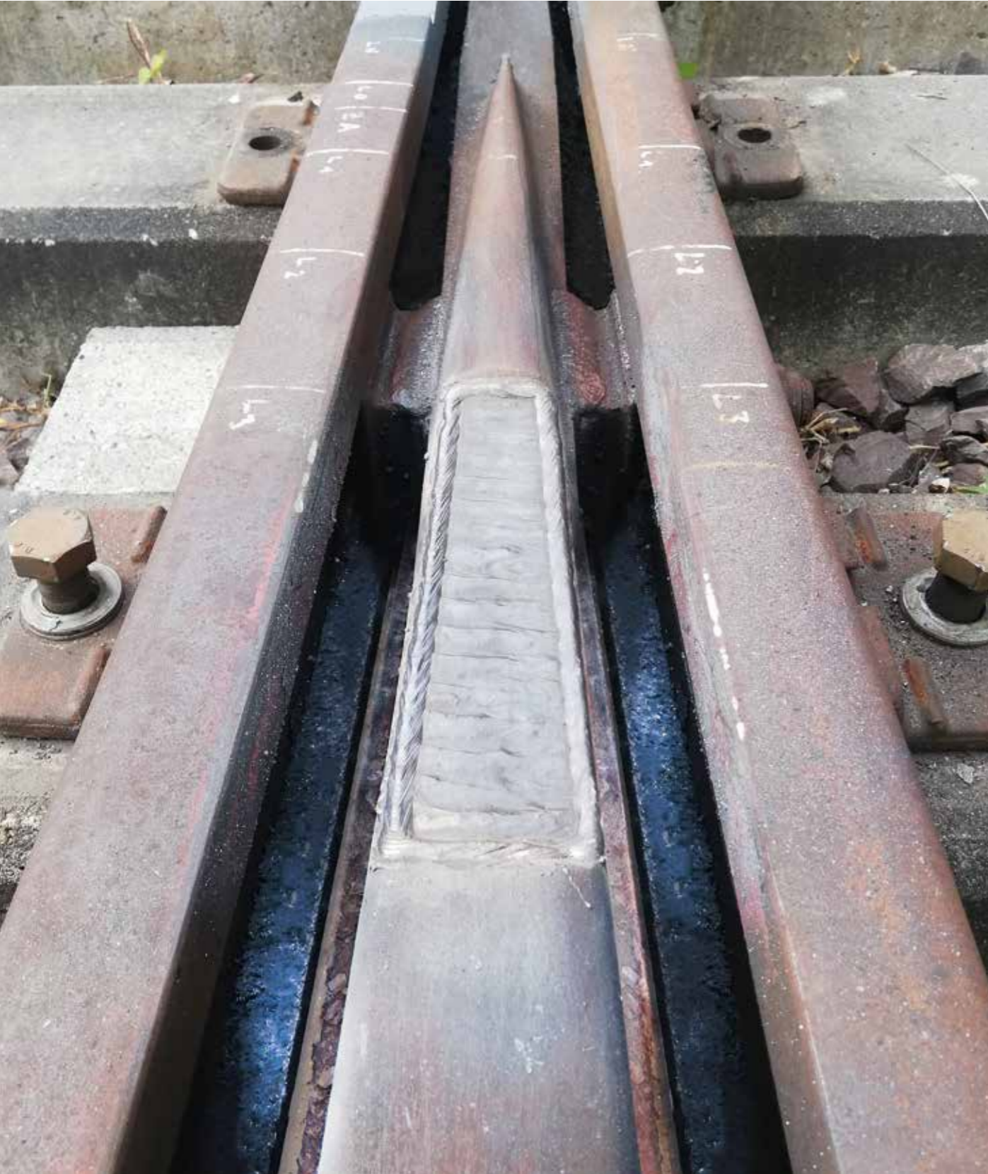
Reparación de cruces ferroviarios con HARDFACE AP-O.
