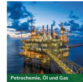
Petrochemie, Öl und Gas
