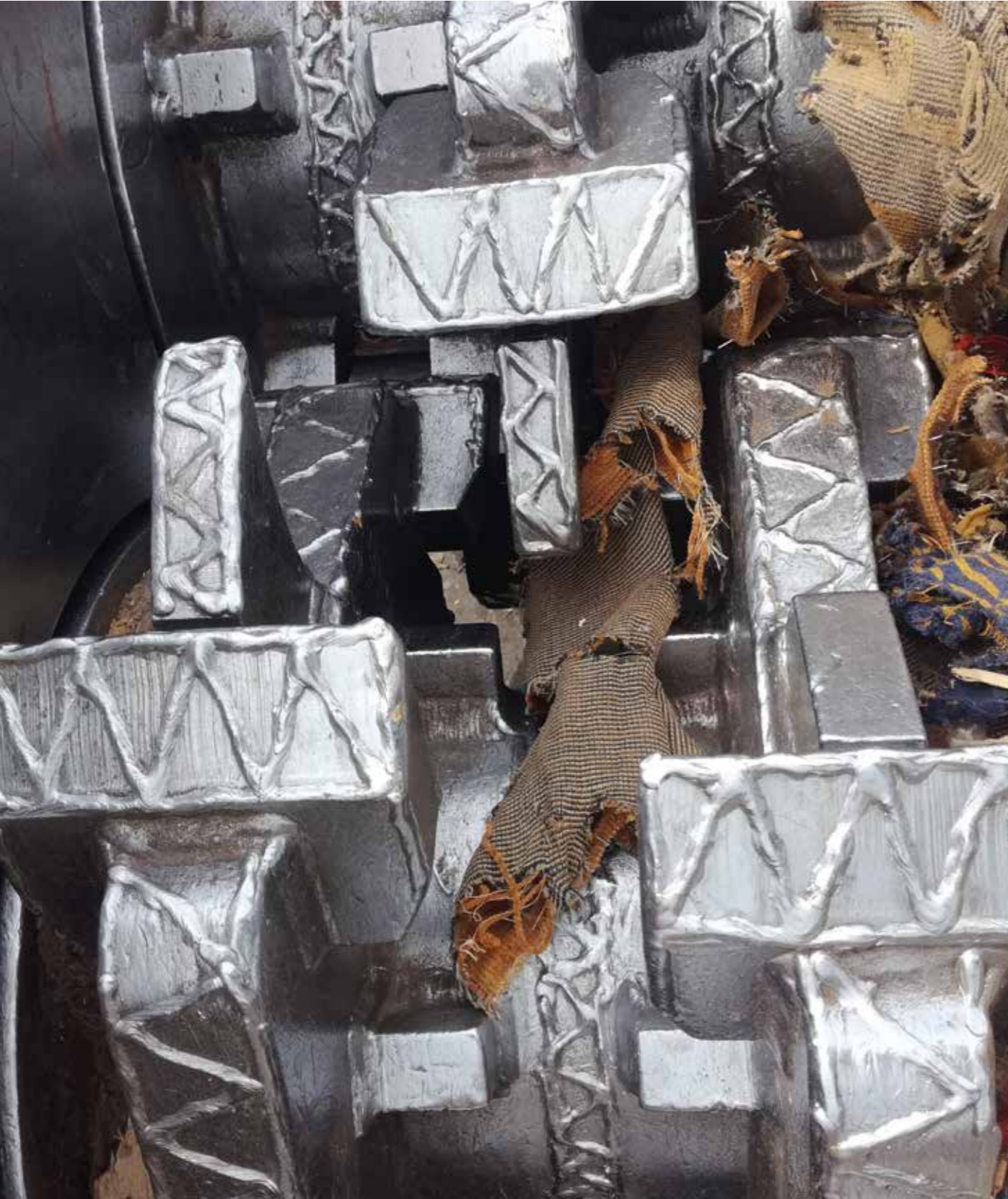
Reparatur eines Schredders mit HARDFACE L-O im eingebauten Zustand.
